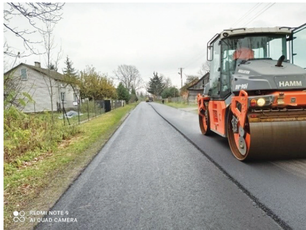
▲ Fot. 17 Prace z zakresu bieżącego utrzymania dróg
