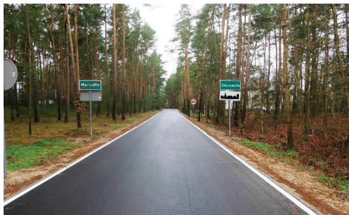
▲ Fot. 20 Wykonanie nakładki w msc. Starowola
