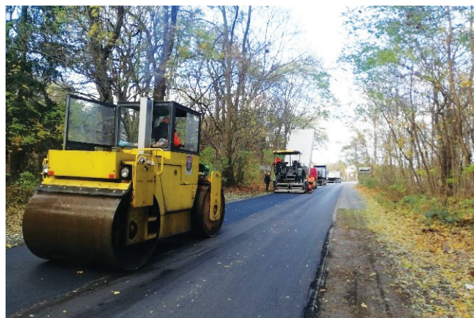
▲ Fot. 19 Prace związane z wykonaniem nakładki i poboczy
